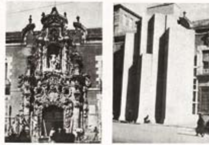
Protección de la portada barroca del Hospital.
