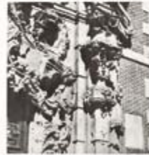
Protección de la portada barroca del Hospital.
