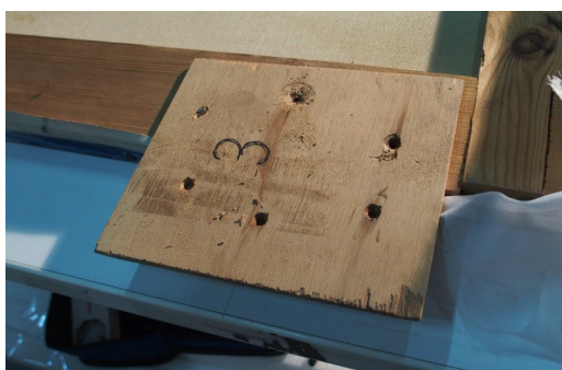
Limpieza reverso/eliminación parche y panel de contrachapado.
