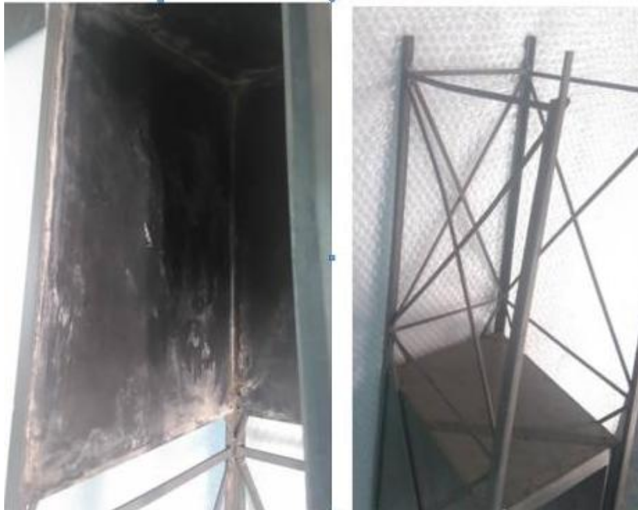
Interior de la estructura de la cabina y parte superior de la misma
