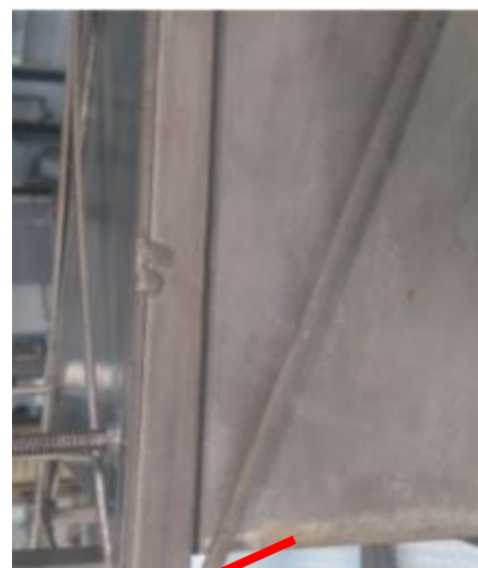
Productos de corrosión
