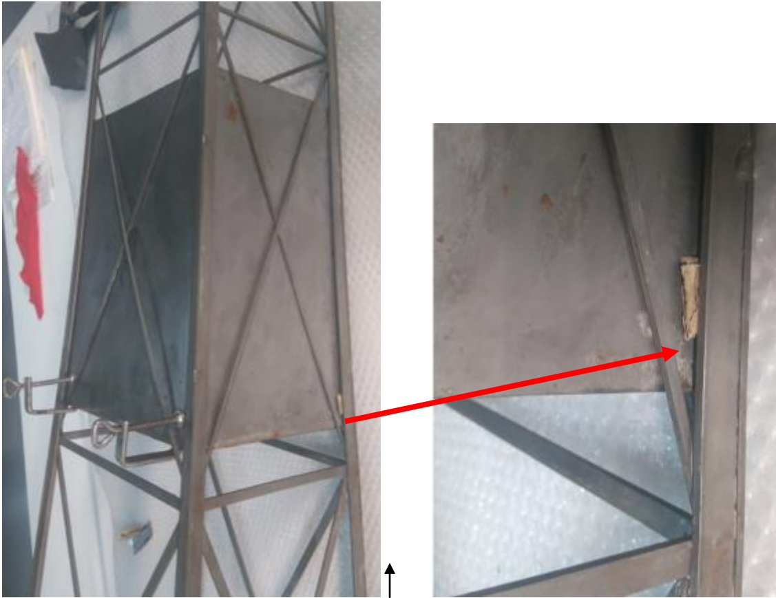
La estructura de la cabina se calzaba con pequeños trozos de cartón en ambos lados, además de la sujeción de los 2 gatos.
