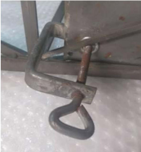
Gato oxidado, erosiones y pérdidas
