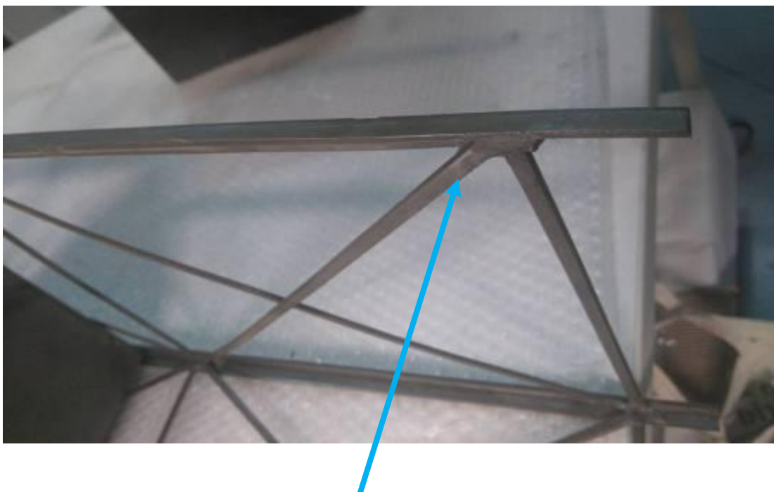
Detalle de la varilla enderezada y soldada.
