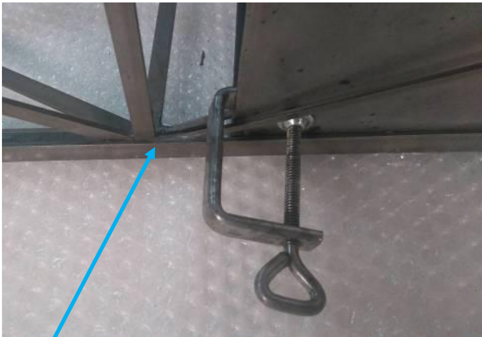
Detalle de la varilla enderezada y soldada en su sitio correcto y del gato limpio
