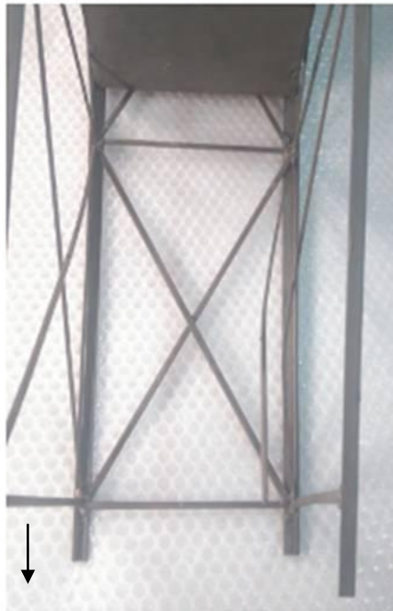
Zona superior dañada. Detalle
