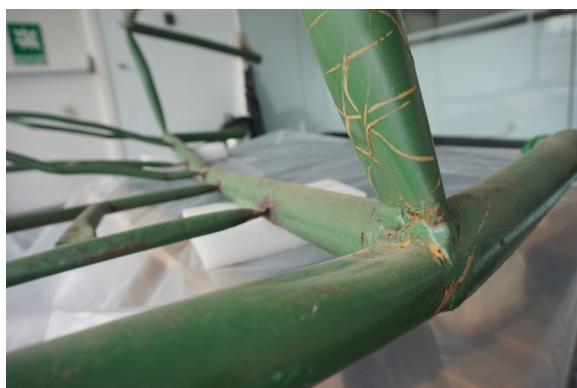
Detalle de manchas de cinta amarillenta
