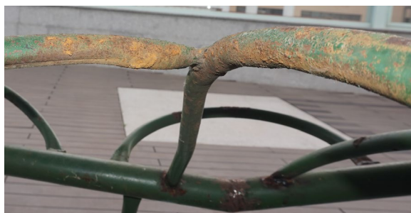
Detalle del efecto de la oxidación
