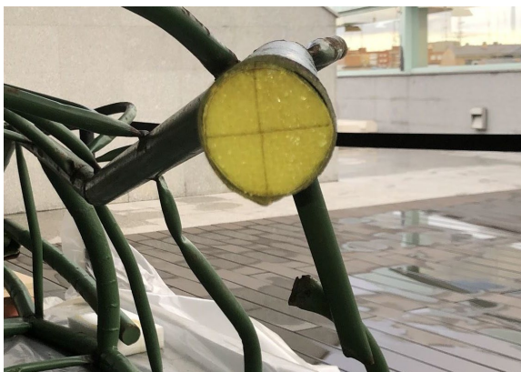
Proceso de colocación de la tapa nueva fijada con soldadura fría y masilla reestructora
