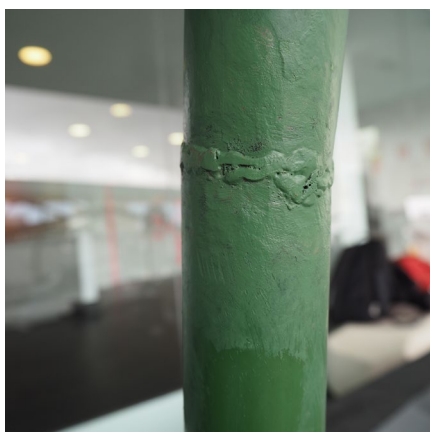
Repinte antes de su eliminación
