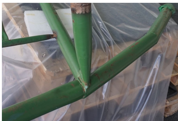
Detalle después de la limpieza
