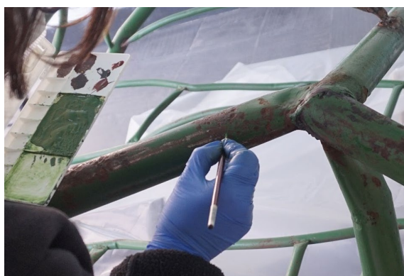
Proceso de reintegración de las pérdidas
