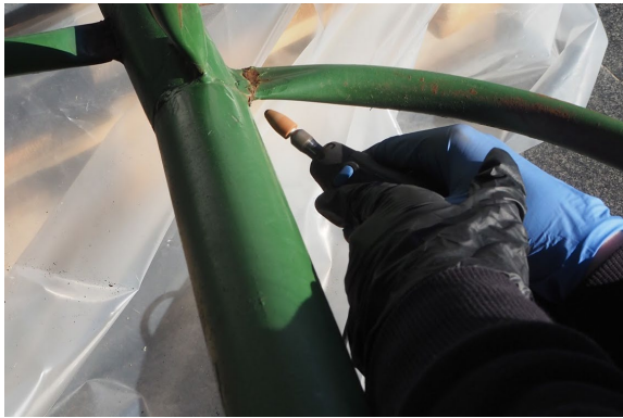
Eliminación de óxidos con muela de óxido de aluminio
