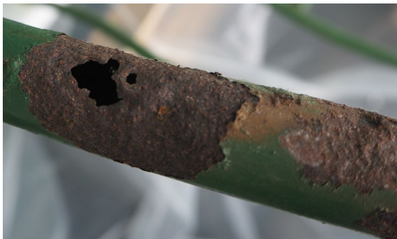
Detalle de pérdida de material en barrote superior
