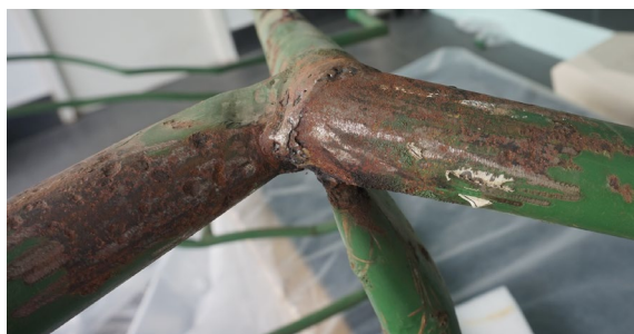
Detalle de oxidación en unión sin protección
