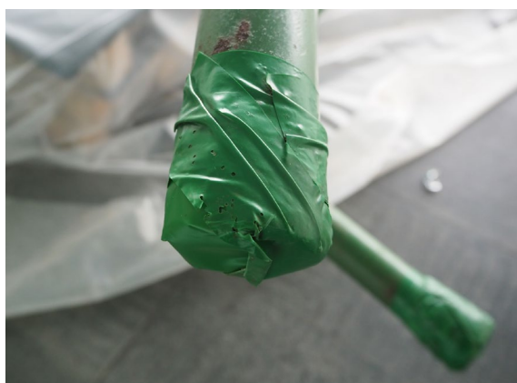
Aspecto final de las protecciones restauradas
