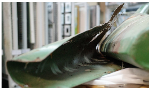
Detalle de la separación entre la cara y la cabeza en la parte superior
