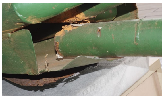
Detalle de la pérdida de soldadura entre la cabeza y barra central
