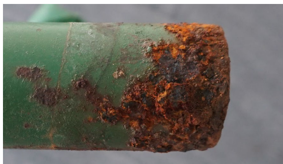
Estado de conservación del metal de una pata debajo de la cinta
