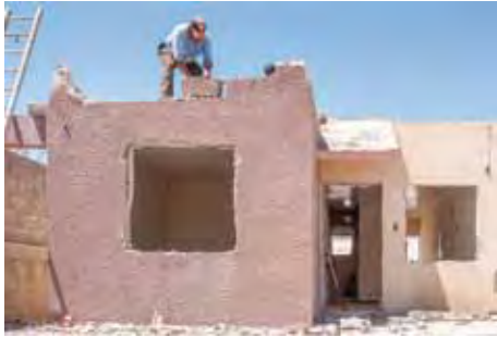
Desmantelado de bloques perimetrales. Dismantling of perimetric parapet.
