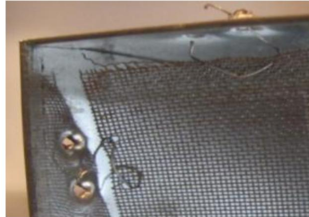
Rejilla metálica: sujeción por cables
