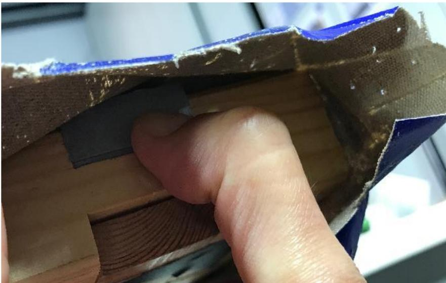
Colocación de la pieza de cartón a medida para suplementar el hueco del bastidor
